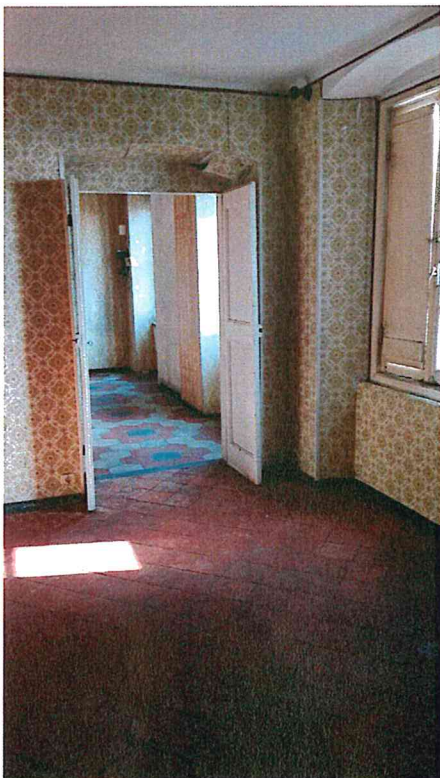
Foto 4 – Camera lato sud
