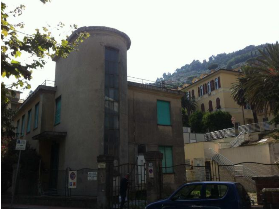
Foto 2 - vista da nord
