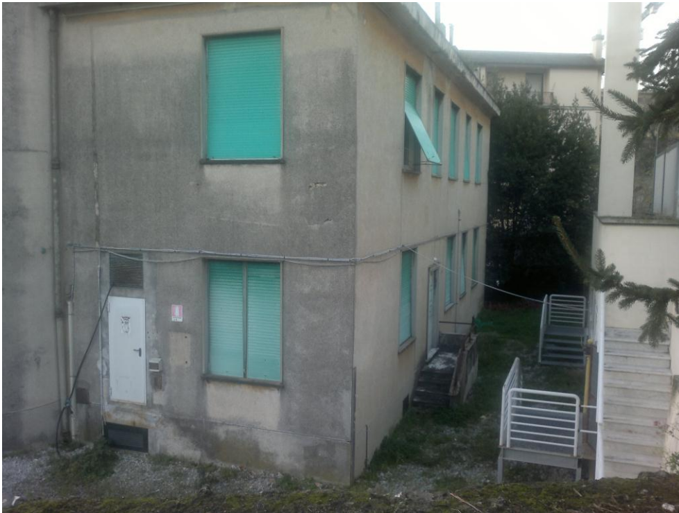
Foto 3 - vista del cortile sul retro
