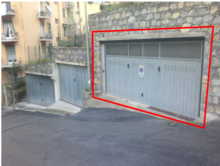
Foto 2 - Serranda basculante di ingresso al box
