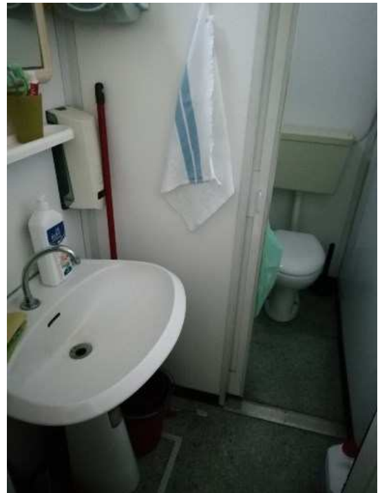
Foto 7 Vista del servizio igienico
