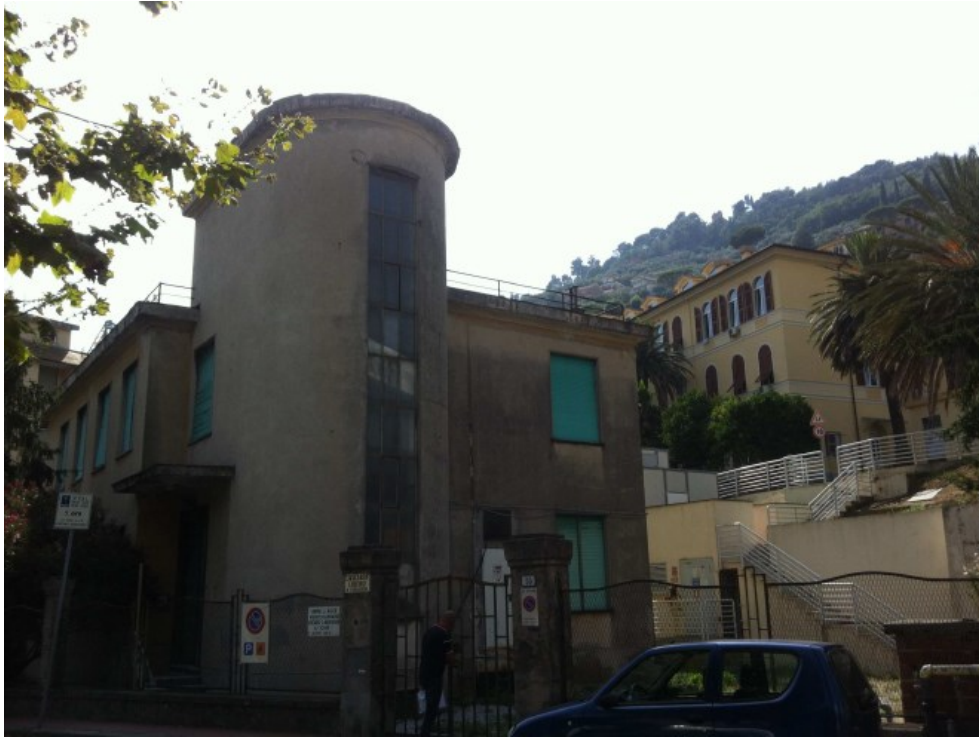
Foto 2 - vista da nord
