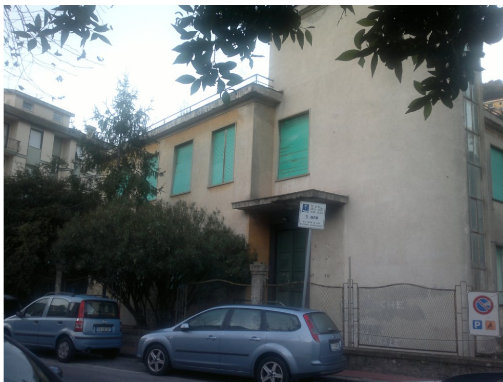
Foto 4 - vista dell'ingresso principale
