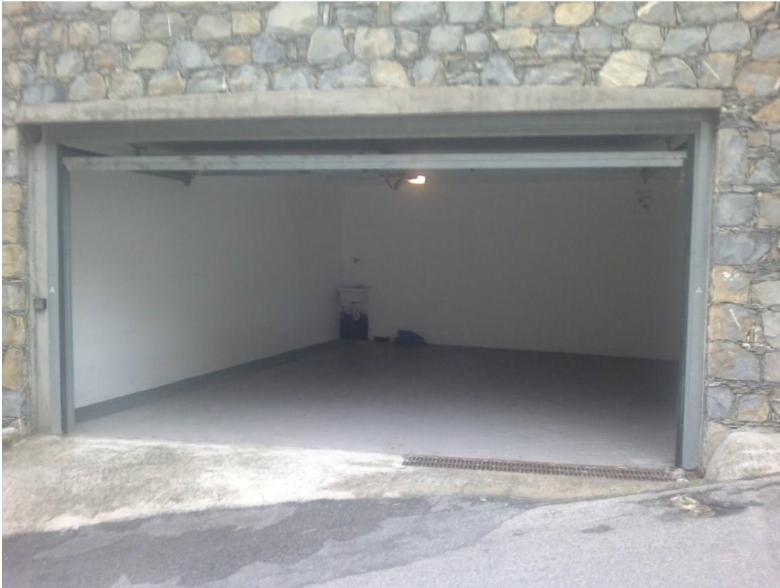
Foto 3 - Interno del box
