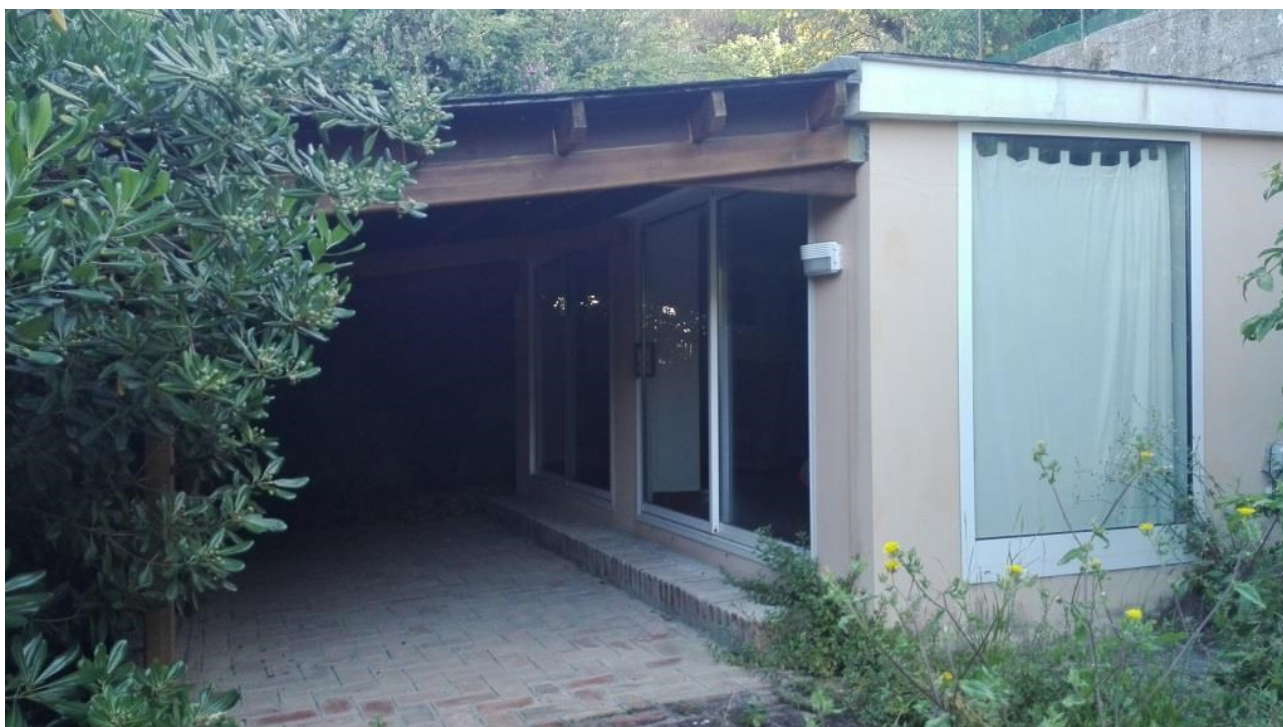
Foto 2 - Vista dal giardino
