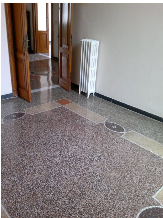
Foto 5 - Una camera - particolare del pavimento
