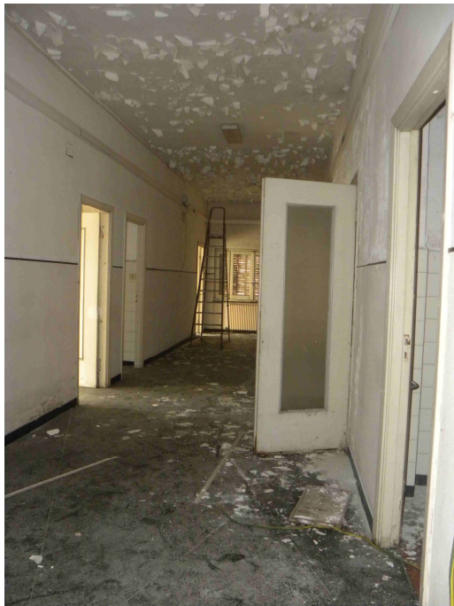
Foto 5 – Corridoio primo piano
