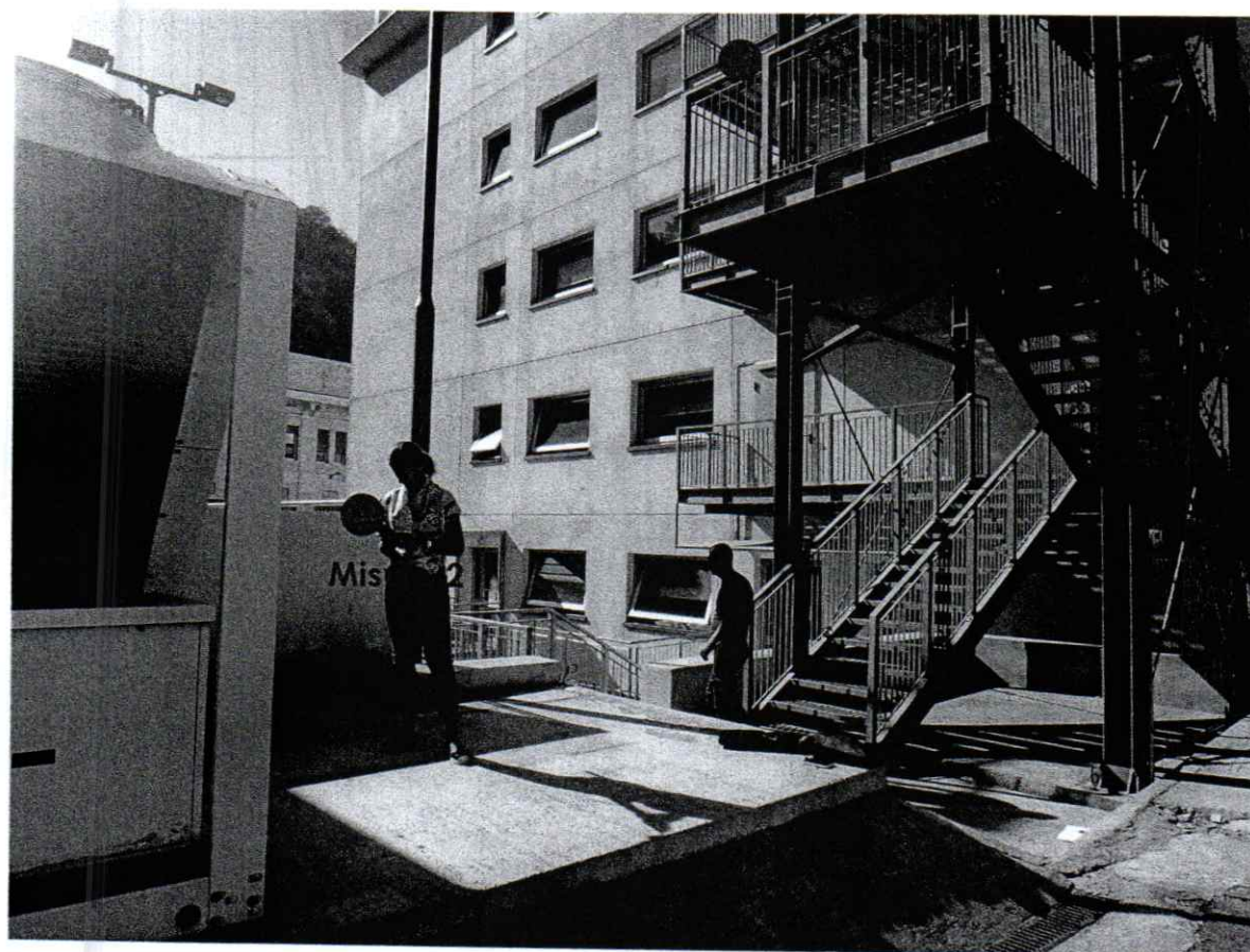
Figura 1 – Fasi di rilievo strumentale per la caratterizzazione del gruppo frigo.
